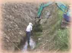
水路の泥上げ
