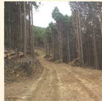
森林整備や木材の搬出などをする林業機械の通行を想定し、構造物は設置せず、メンテナンスしながら利用される道
