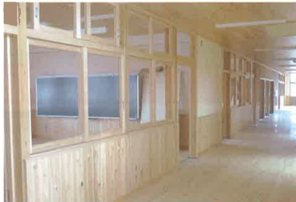
<施設の木質化の事例>
