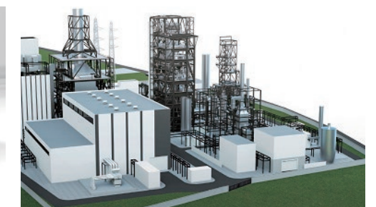
石炭ガス化複合発電プラント(IGCC) 石炭をガス化することで従来の石炭火力発電より大幅な燃焼効率の向上を実現したプラント
