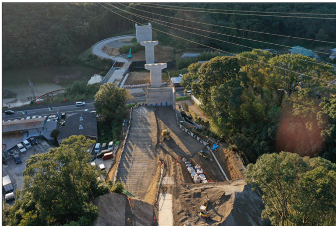
現場状況 (R2. 11月末時点)
