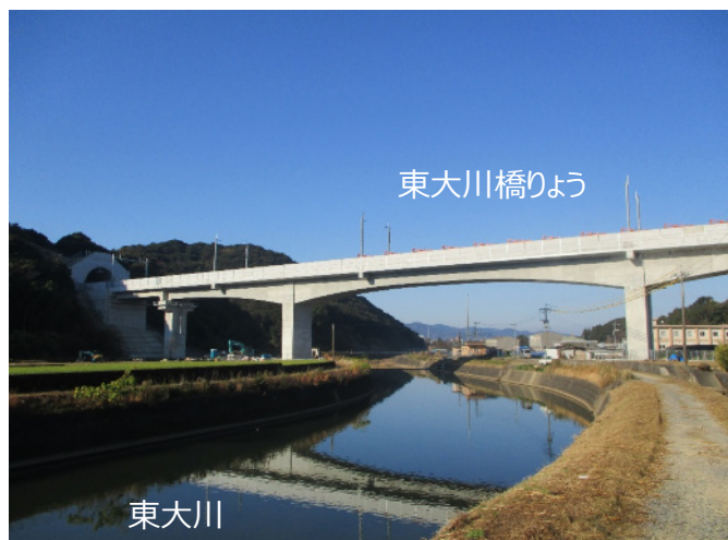
完成した東大川橋りょう
