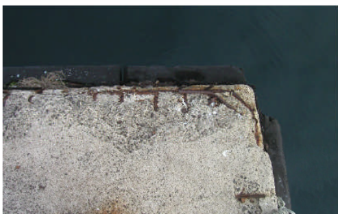
ボンツーン部の鉄筋露出
