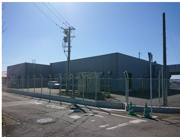
新大村信通機器室
