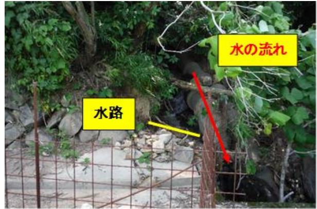
図5 河川への流入水路の状況
