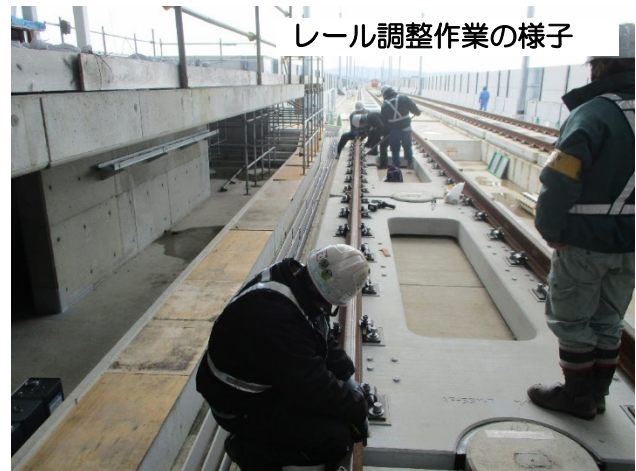
レールの通りを確認している様子
