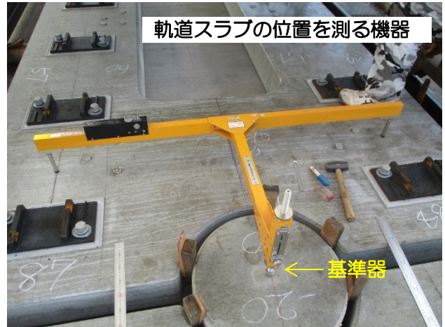
軌道スラブの調整作業の様子
