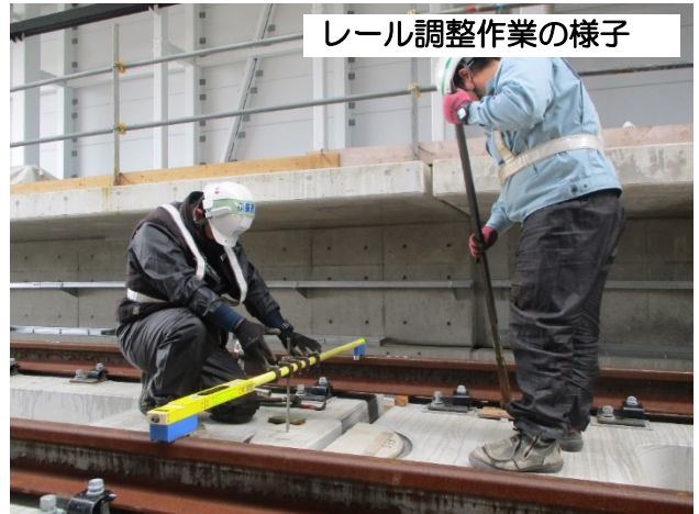
レール調整作業の様子
