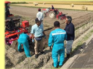
水田畑地化作業（明きょ設置）
