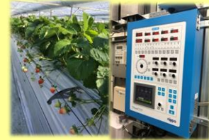
左：いちご省力品種「恋みのり」 右：統合環境制御盤
