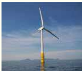
世界初のハイブリッドスパー型浮体式洋上風力発電
