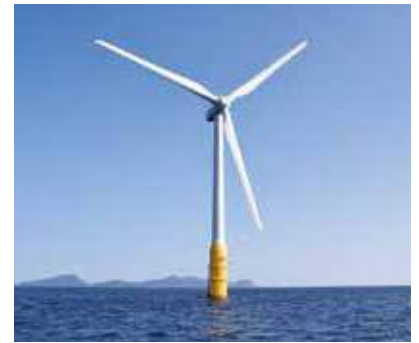
五島市沖浮体式洋上風力発電「はえんかぜ」
