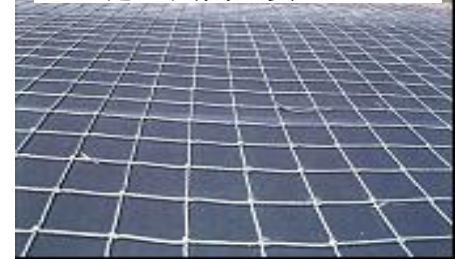
ため池の法面の安全ネット
