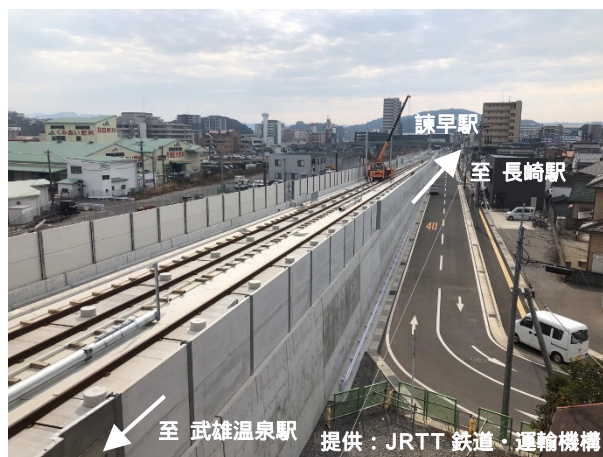
竣工した「諫早駅路盤」工区 （駅より北側の擁壁部）
