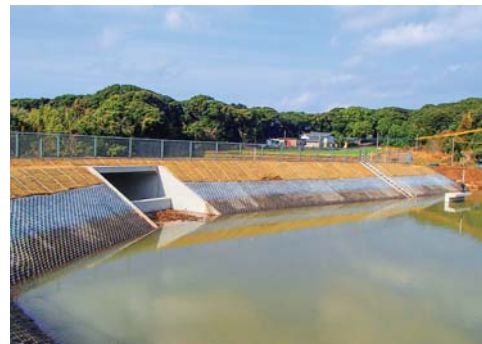
老朽ため池の整備（郷ノ浦町「泉ヶ山ため池」）
