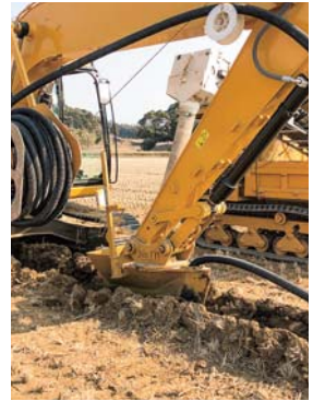
フォアスの施工
