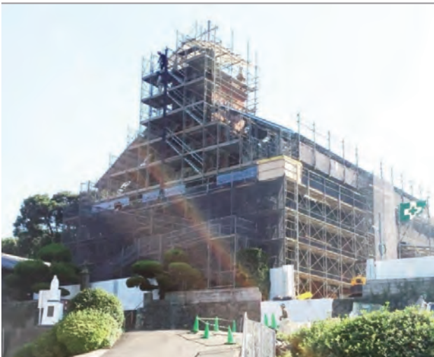
大規模な耐震・保存修理工事中の黒島天主堂
