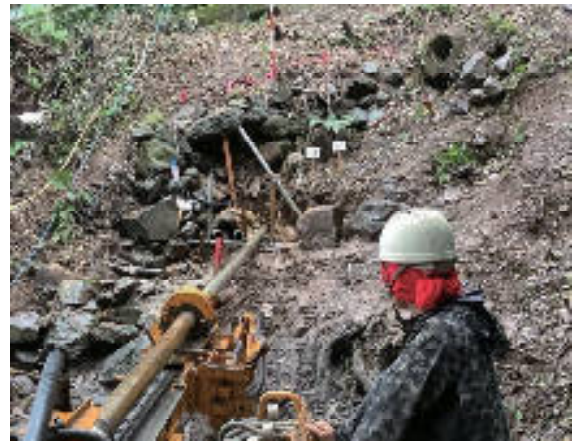
地すべりの主な原因である地下水を抜くための工事
