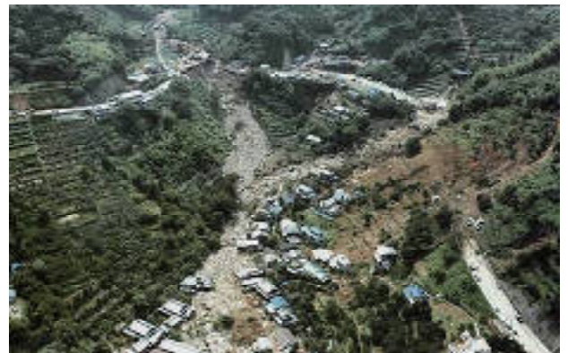
多くの死傷者が発生した土石流（昭和57年 長崎市）提供/DEITz
