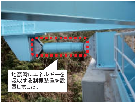
〈主要地方道平戸生月線 平戸市 生月大橋〉
