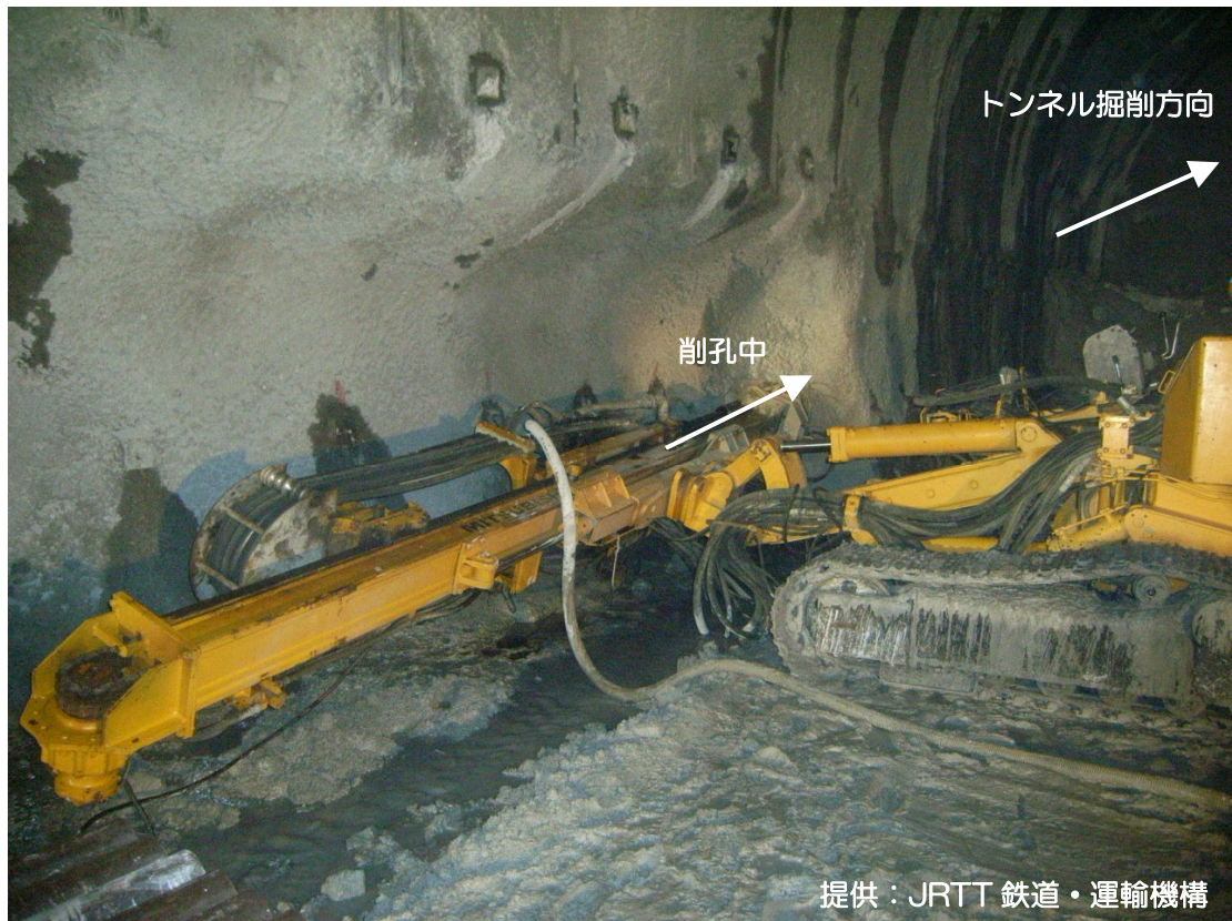
水抜きボーリング施工状況
