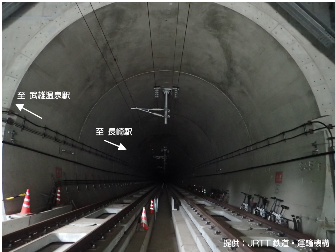
完成した新長崎トンネルの入口（東側）
