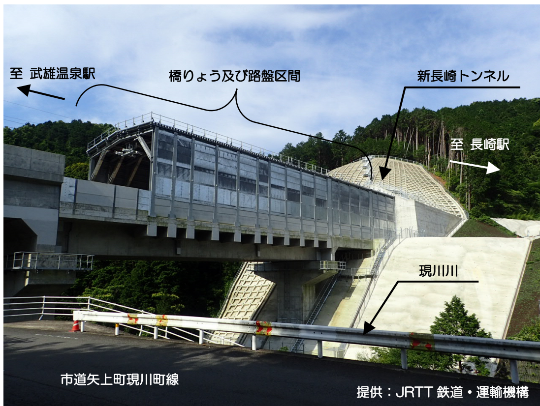
完成した新長崎トンネル坑口付近（東側）
