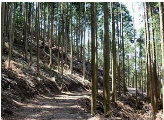
森林作業道の開設
