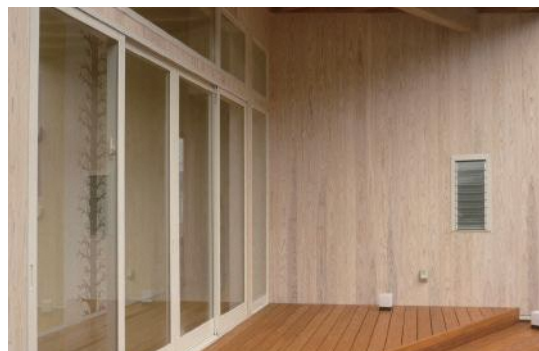
多くの方が利用する施設や、学校などの木質化および木製品の整備を支援し、県産材の利用促進につなげています。
