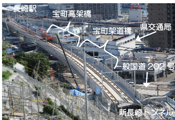
完成した宝町橋りょう
