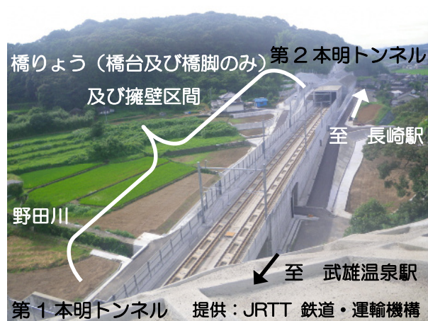
完成した第1本明トンネルと第2本明トンネルの間
