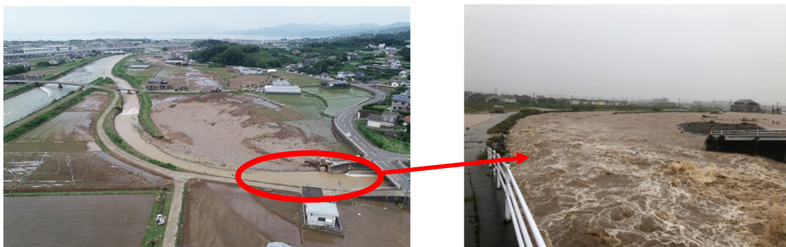
図5 7 本県における豪雨災害（令和2年(2020年)7月豪雨 大村市） 堤防が一部決壊
