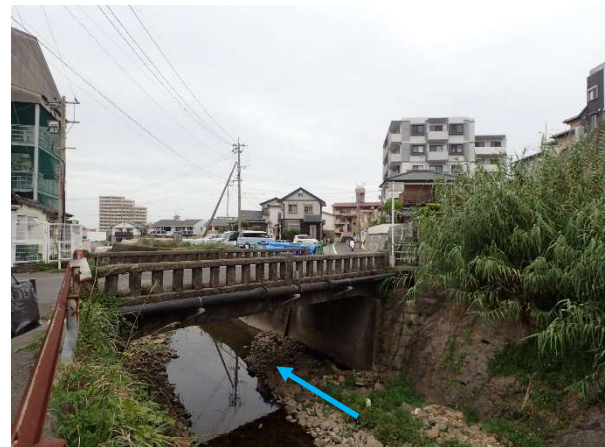
令和3年度施工区間（鳥越橋）
