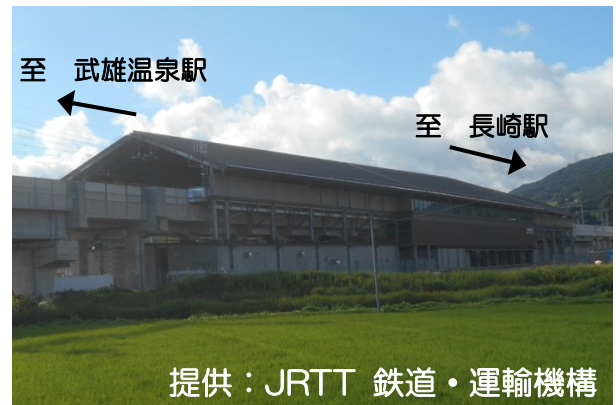
嬉野温泉(仮称) 駅外 1 箇所新築工事 (嬉野温泉駅温泉口側)
