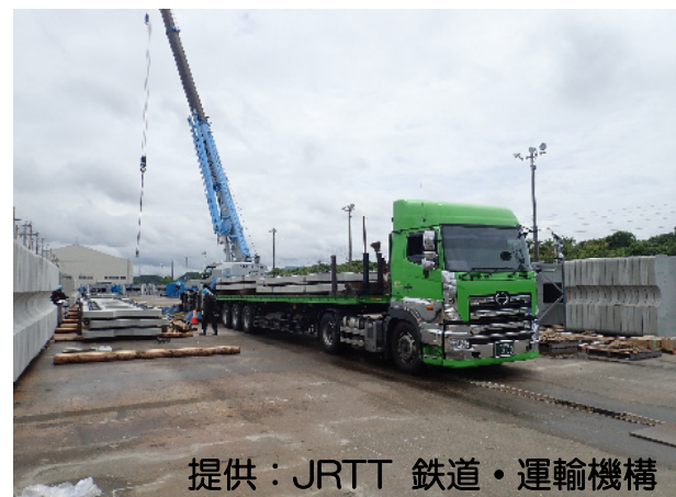
大村・長崎間軌道スラブ製作運搬工事 (工場から運搬している様子)
