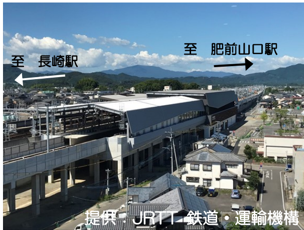
武雄温泉駅外 1 箇所新築工事 (武雄温泉駅全景)
