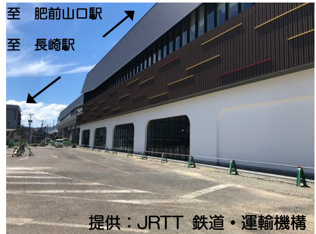
武雄温泉駅外 1 箇所新築工事 (武雄温泉駅南口側)
