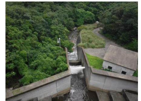
ダム下流放流状況 事前放流後
