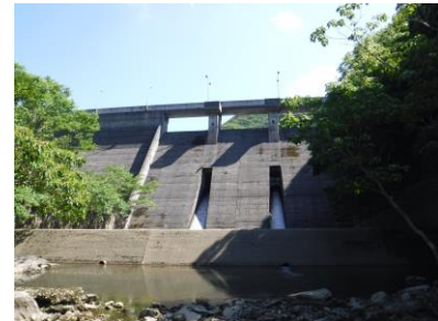
（ゲートレスダム）仁田ダム 〈所在地：対馬市〉
