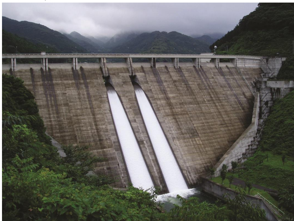
萱瀬ダム（所在地：大村市）
