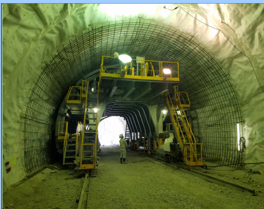
トンネル工事施工状況
