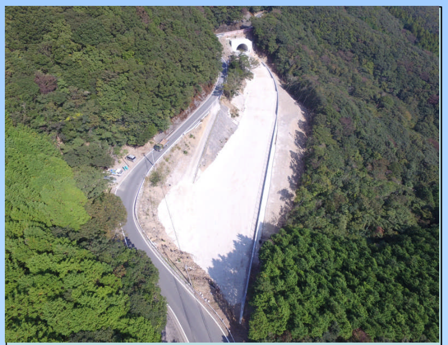
トンネル安神側状況(R3.10末)
