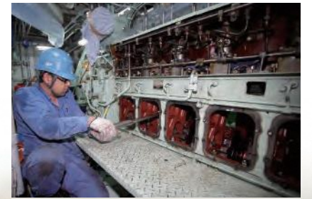
主エンジン部分修繕の作業風景
