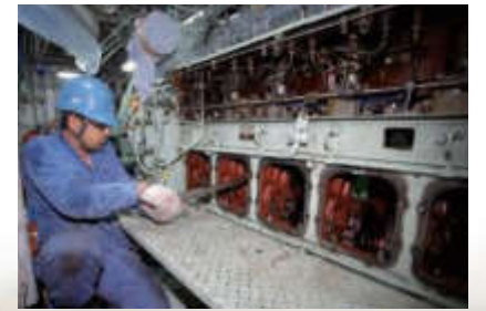
主エンジン部分修繕の作業風景
