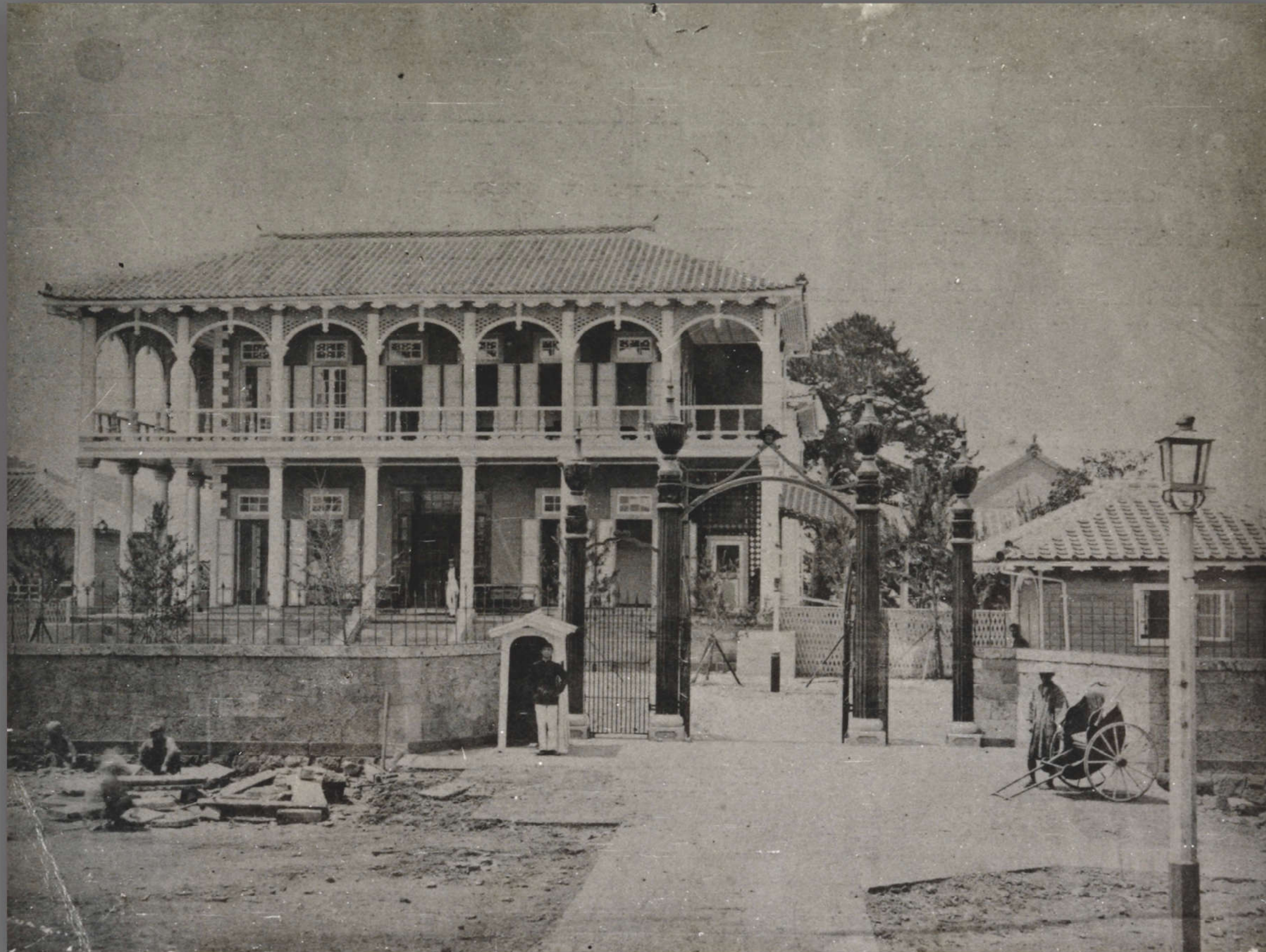
竣工時の初代長崎県庁舎<長崎関係古写真集(複写)>
