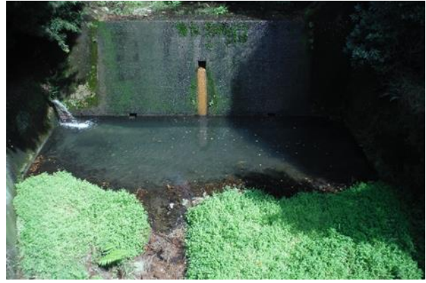
図5 地点11上流の砂防ダム
