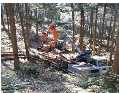
高性能林業機械による作業
