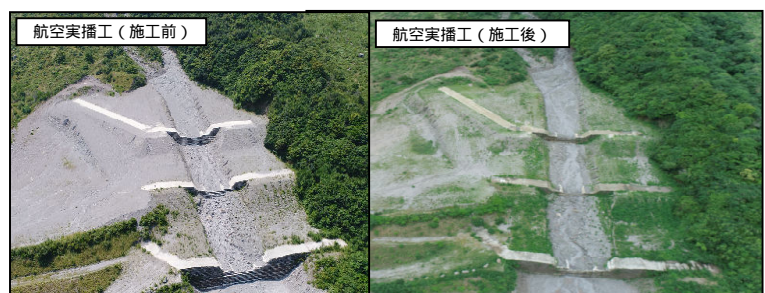
治山工事：治山ダム(谷止工)5号~7号
