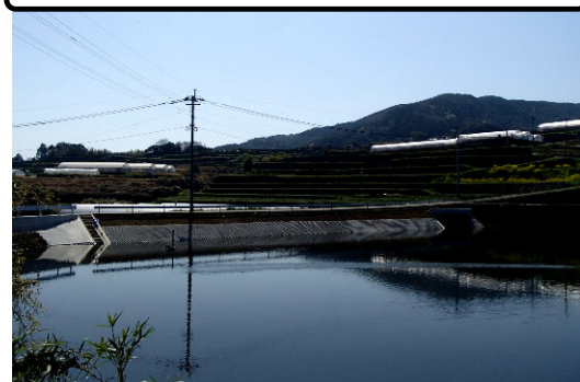
ため池の整備：柳ノ池ため池（南島原市）
