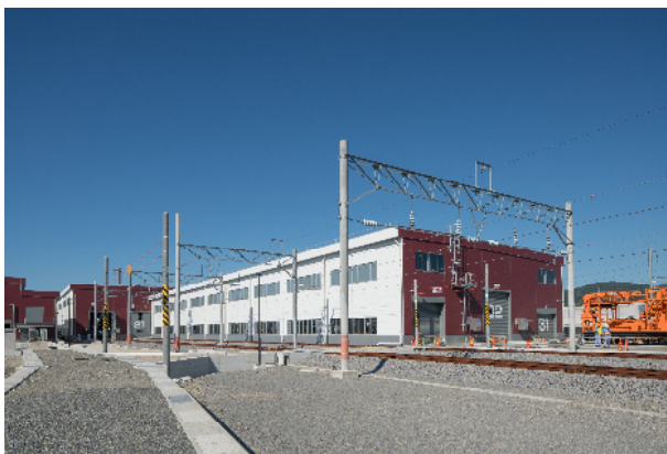
台振庫（台車振替・臨時修繕・車輪転削庫）
