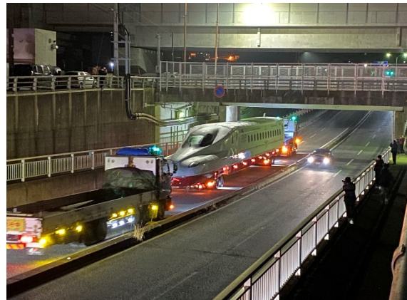
大村市植松 (JR 大村線と新幹線本線のアンダー)
