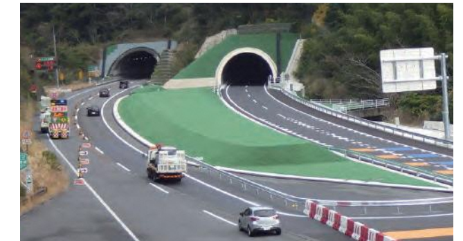
長崎トンネル(長崎IC側)
