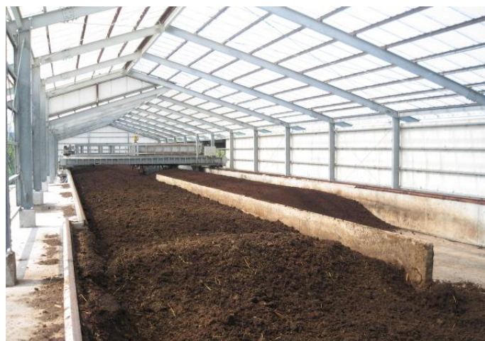
攪拌型堆肥化施設
