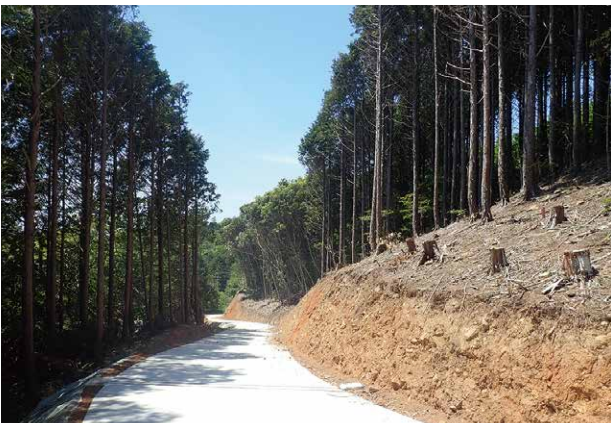
林業専用道の整備
