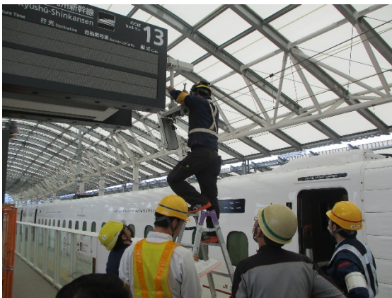
ホームを映すカメラを確認する様子
