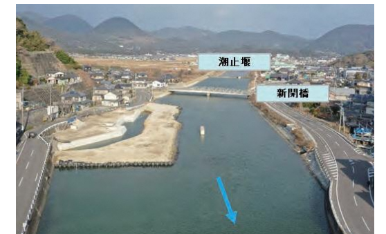
江ノ浦川(諫早市)の河川改修工事
