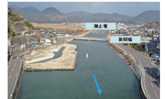
江ノ浦川(諫早市)の河川改修工事
