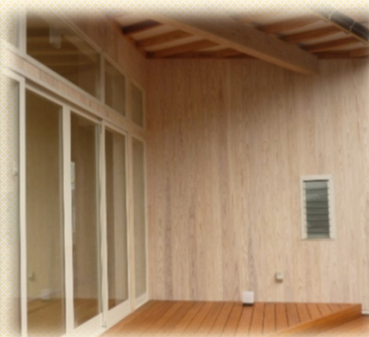
外壁・ウッドデッキ
