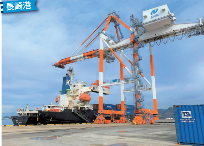
ガントリークレーンによりコンテナを船積み
