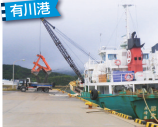
砂・砂利などの建設資材も取扱う
