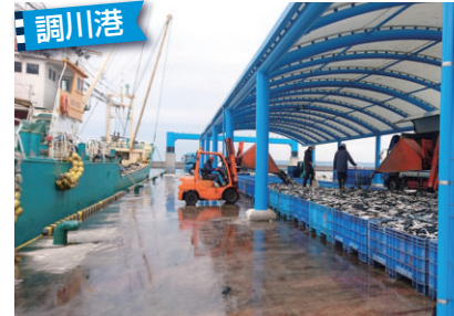
浮桟橋を整備し作業を効率化
