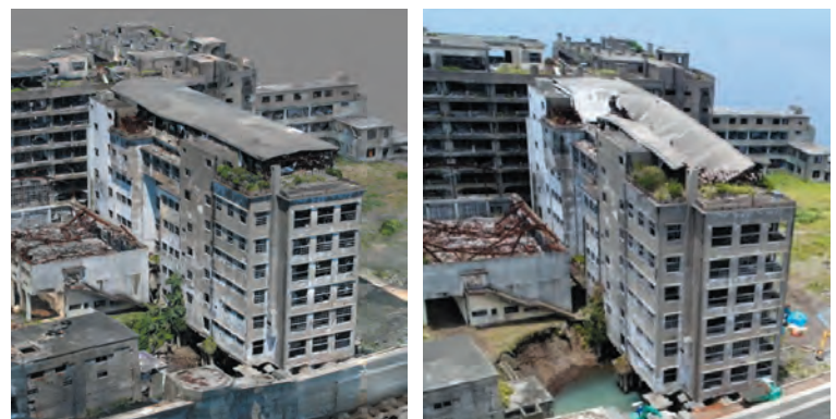
平成26年 → 平成29年 コンクリート建造物の風化が日々進行している「端島炭坑」
