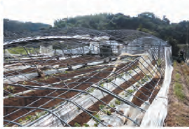
全壊したメロンハウス (松浦市)
