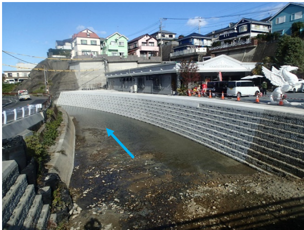
令和2年度整備済区間（長坂橋下流右岸護岸）
