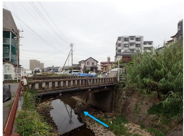
令和3年度施工区間（鳥越橋）
