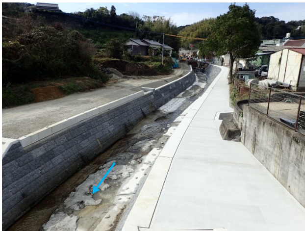
令和2年度整備済区間（文明堂上流護岸）
