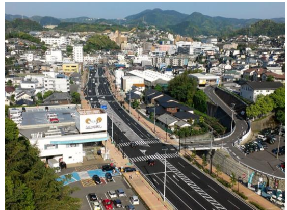
横道工区の供用状況
