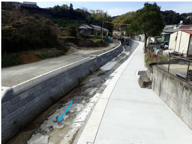
令和3年度施工（護岸工）
