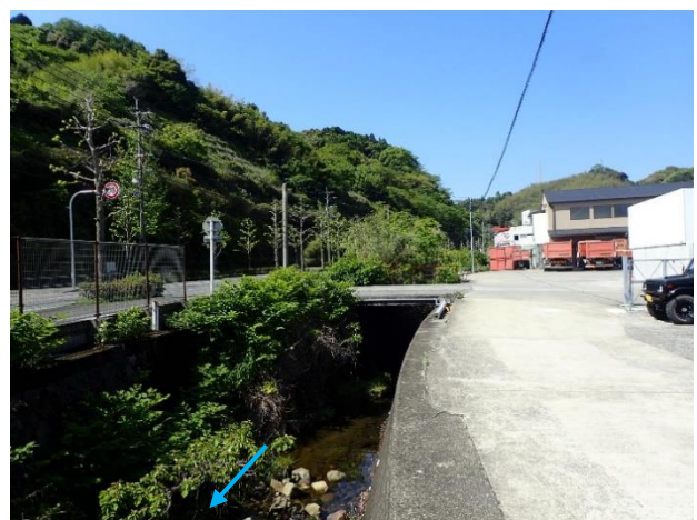
令和4年度施工（函渠工）
