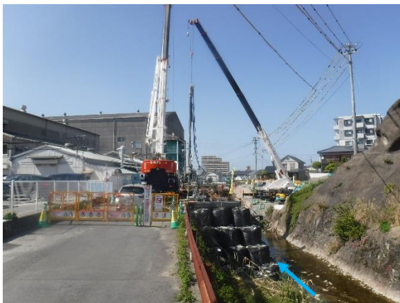
令和3年度施工（鳥越橋下部工）
