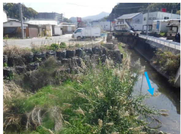
令和4年度施工（護岸工）
