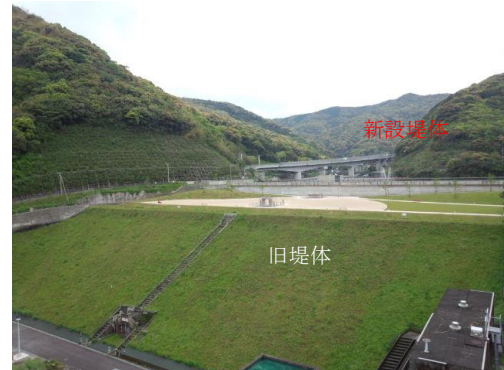
新旧堤体間の公園整備（平成 25 年 3 月完了）
