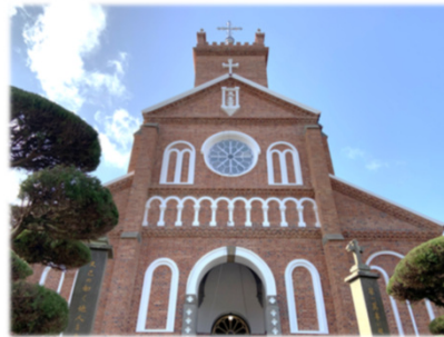
修復工事を終えた黒島天主堂(佐世保市)
