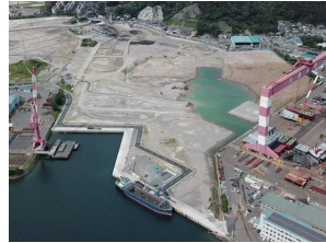
埋立工事が進められている馬込地区
